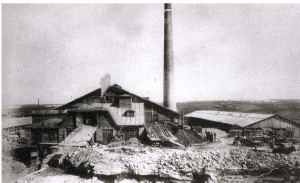
Печь была запатентована в Германии **Фредериком Гофманом** в 1858 году. Она произвела революцию в производстве кирпича и плитки. «Печь Гофмана» или «кольцевая печь» представляла собой массивную печь, в которой изделия обжигались при
