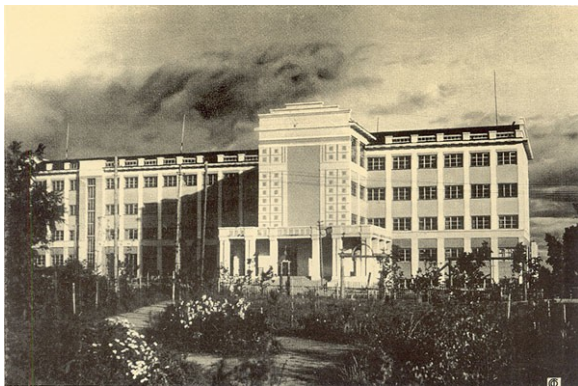
Один из корпусов института по ул. Ленинградской, 113
